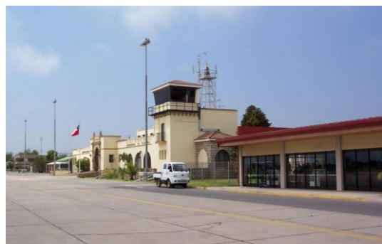
terminal aeroportuario concesionado.
