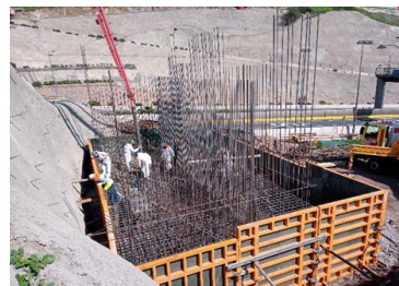
(31.08.20) Estribo 2 Hormigón de Fundación Mezcla GB-30(90)20/12 volumen 140m³.
