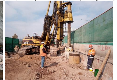
(19.08.2020), Ramal Mapocho. Se excava el Pilote IZQ 3 secante.
