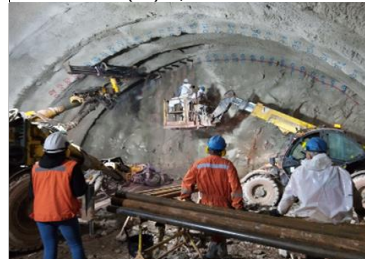
(18.08.2020), Se excava a sección completa en tobas brechosas. Frente se encuentra en el Dm 2.296,75, en Marco 467.
