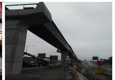
(23.08.20), Viaducto El Salto. Vigas 6-7-8-9, montaje realizado el 21 y 23 agosto.
