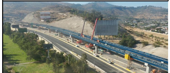
Viaducto El Salto - vista panorámica todas las vigas instaladas.
