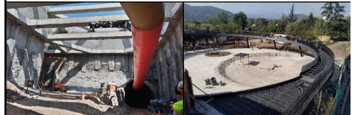
Conexión de Pique Ventilación Vitacura con Túnel La Pirámide
