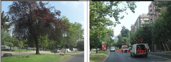
Fiscalización valla peatonal y reparación de aspersor:
