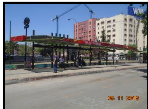
ETT con daños provocados por terceros.
