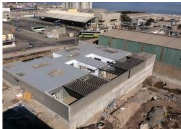
Avance obras civiles Jardín Infantil
