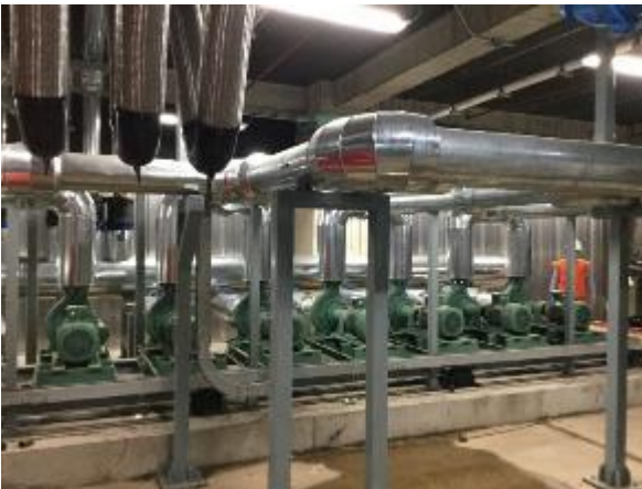
Vista de terminación de la protección de cañerías y accesorios en central térmica
