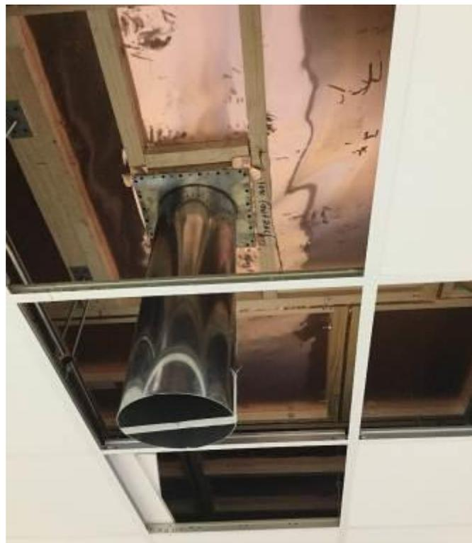
Instalación de ducto Quench para Resonador Nuclear Magnético
