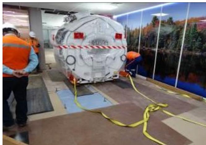
Luego de encontrarse el resonador magnético dentro de la jaula Faraday se comienzan los trabajos de conexión de los requerimientos técnicos y terminación de la sala
