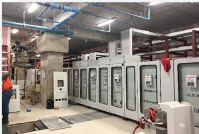
Montaje de Tableros de Principales de Aluminado Fuerza y Calefacción (T.D.A.F y C) en sala de tableros principales del edificio CDT
