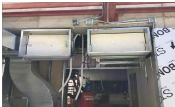
Vista de dos dámper cortafuego en ductos de climatización en auditor
