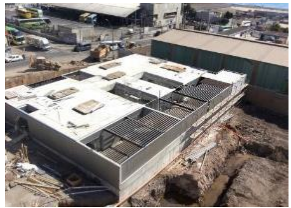
Avance obras civiles Jardín Infantil
