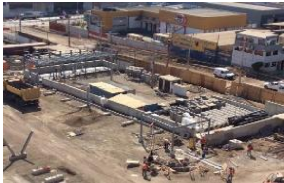
Avance hormigonado de muros multicancha
