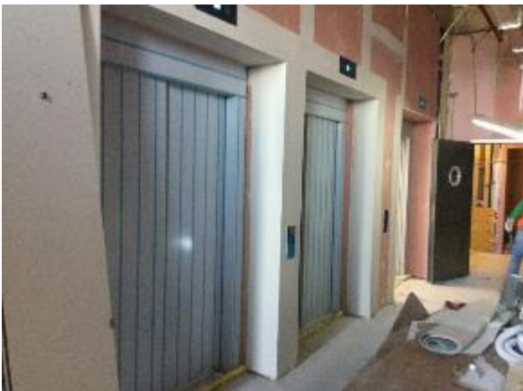
Vista del ascensor de TH A2 del nivel 8 edificio Th
