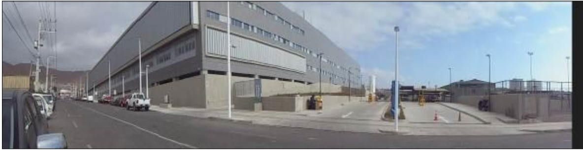
Fachadas Norte y Poniente, acceso estacionamiento funcionarios, todo por calle Montegrande
