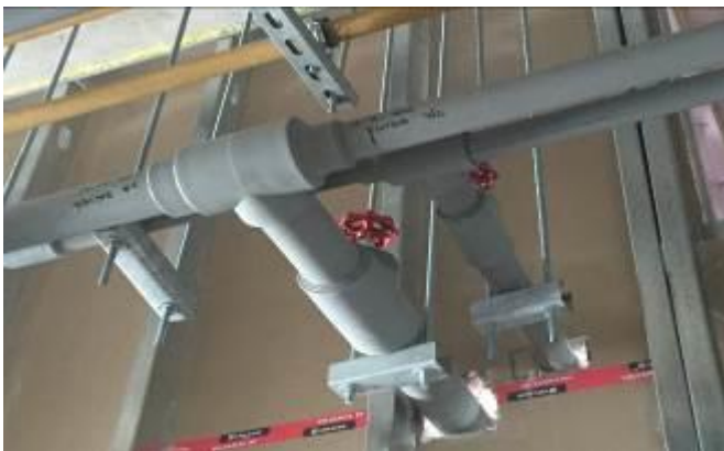
Instalación de cañerías de Fluxores – Soportes posicionados correctamente
