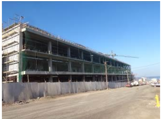
Avance en la colocación de hormigón en edificio CDT
