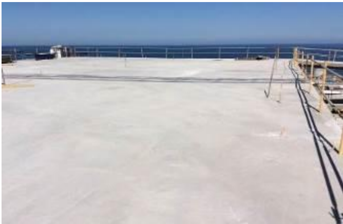
Losa hormigonada en edificio CDT
