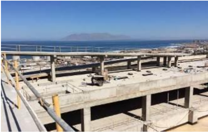
Rampa acceso a losa helipuerto
