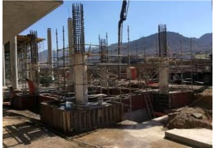
Últimos avances en la colocación de armadura sector UPC
