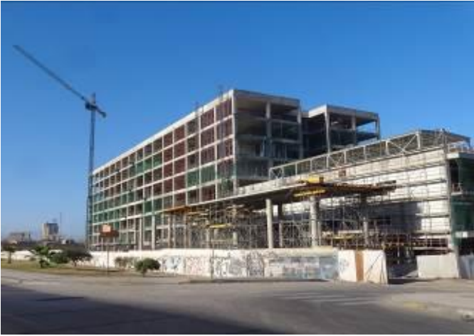
Avance en la colocación de hormigón en edificio Torre Hospitalización TH
