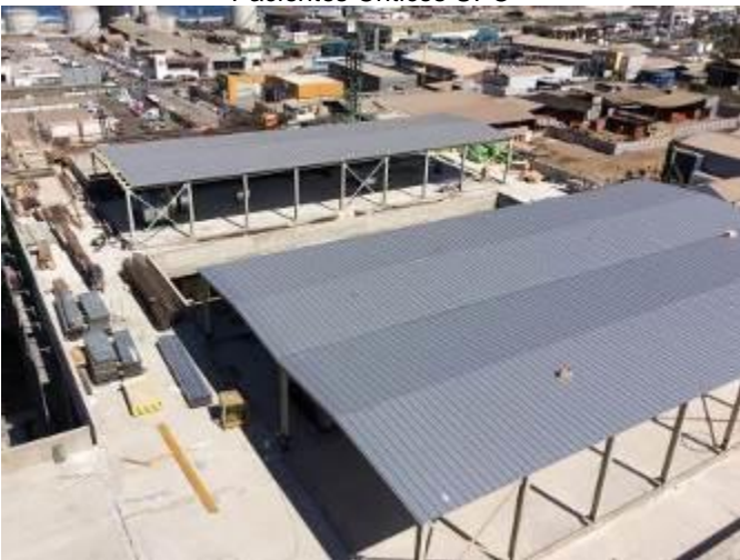
Avance sobrelosa cubierta edificio CDT
