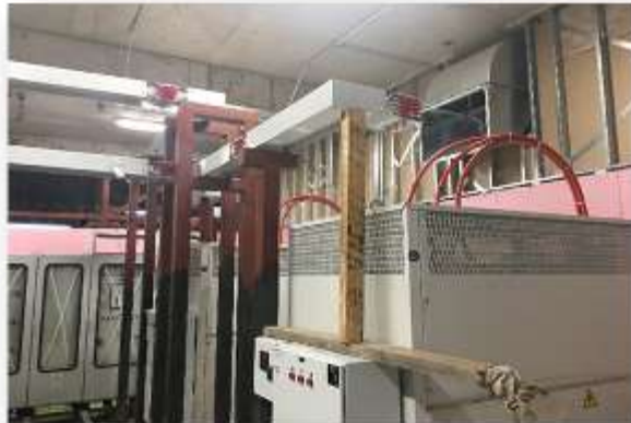
Montaje de ducto de barras desde Transformador hacia tableros generales
