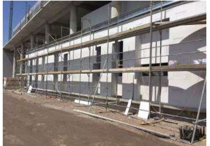
Avance losa con placa colaborante de cafetería
