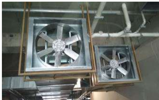
Ventiladores extractores de 9000 [l/s] de sector estacionamiento, nivel -1
