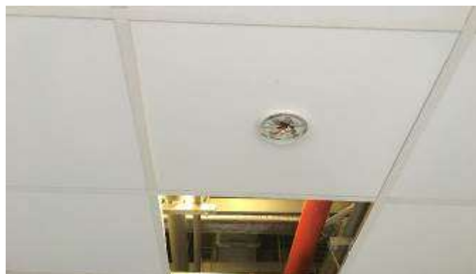
Montaje de bases de detectores de humo en cielos falsos
