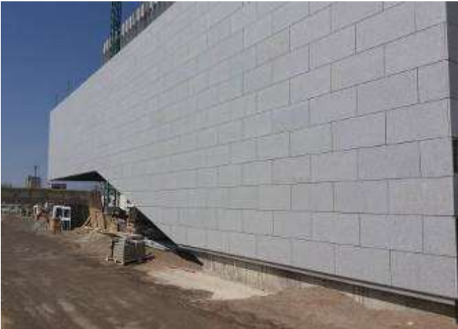
Avance revestimiento auditorio
