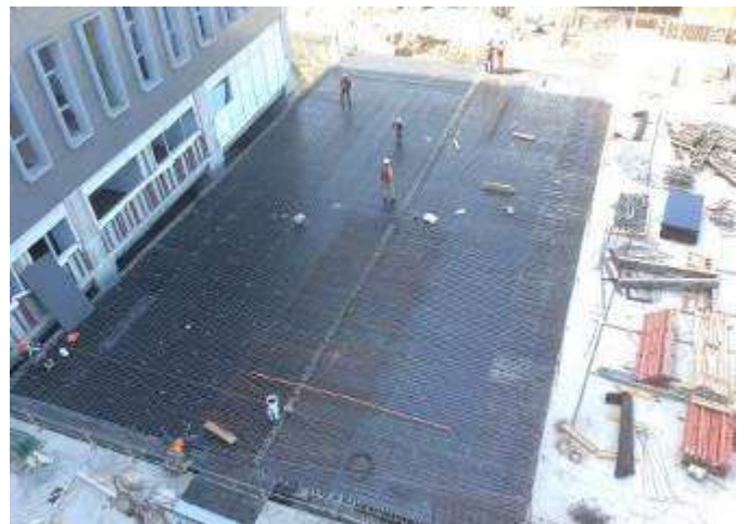
Avance estructura losa de aljibes tramo restante
