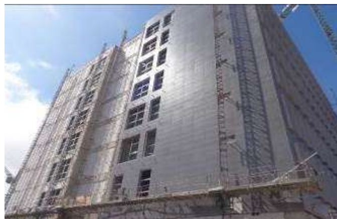
Torre Hospitalización TH
