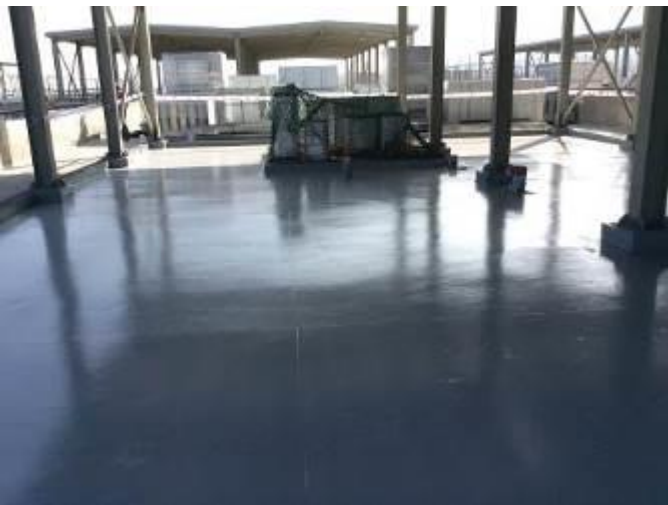
Avance pintura salas técnicas edificio CDT
