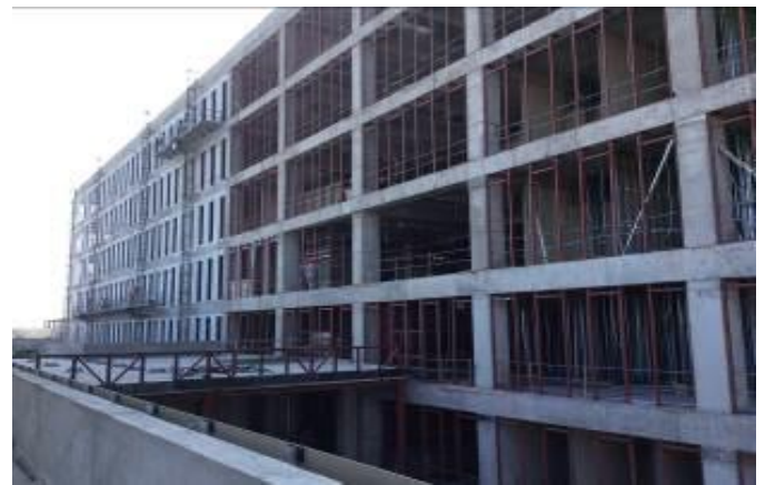
Avance en instalación de fachada en edificio Torre Hospitalización TH
