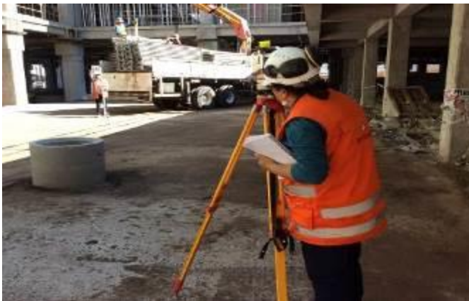
Control de nivel radier edificio UPC (post hormigonado)
