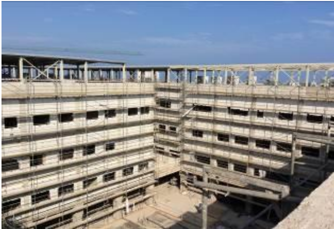
Obra gruesa sector UPC
