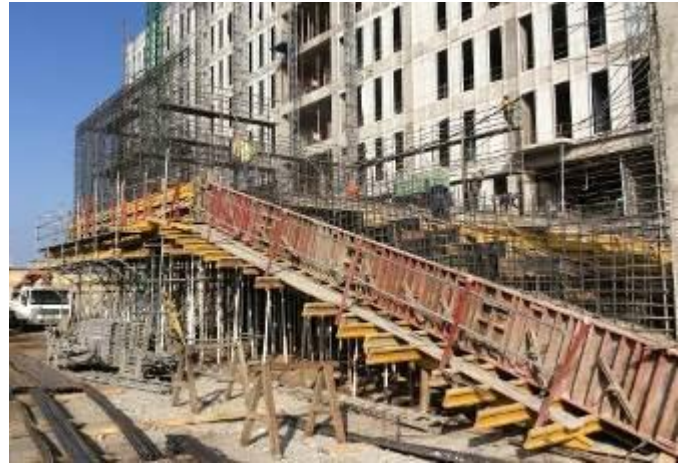
Avances en armaduras sector de auditorio
