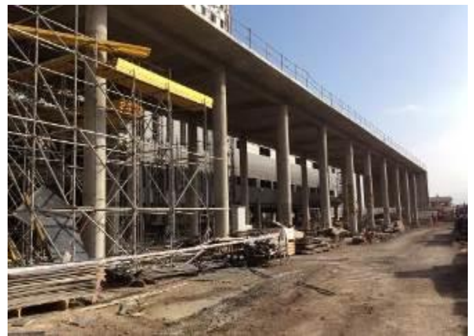
Obra gruesa en el sector entrada principal
