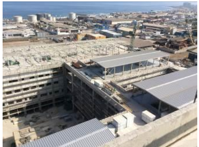
Obra gruesa en edificio CDT
