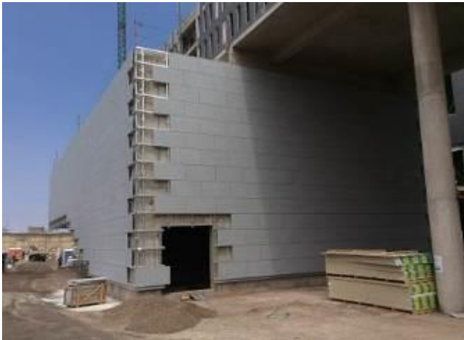
Hormigonado Muro auditorio
