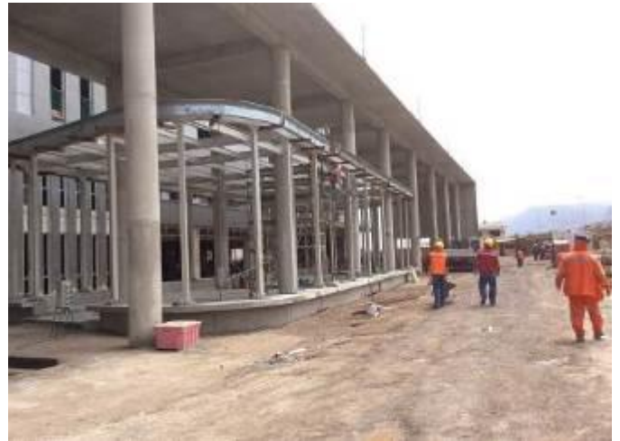
Obra gruesa cafetería
