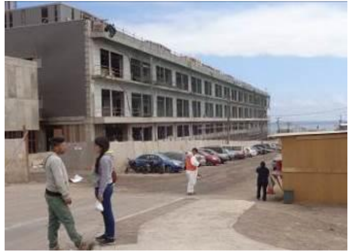
Obra gruesa en edificio CDT
