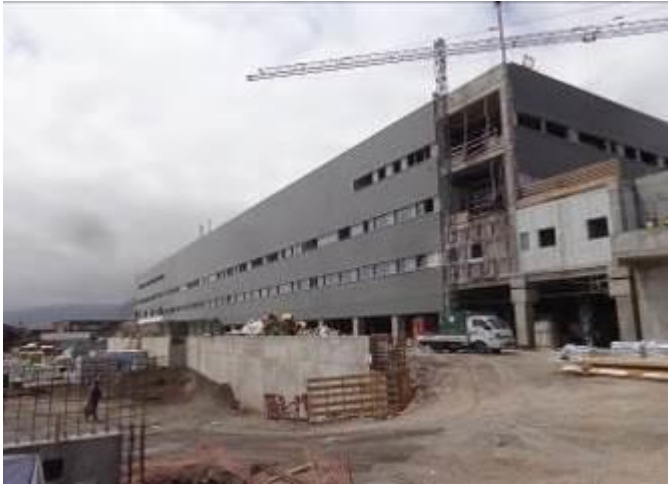
Obra gruesa en edificio UPC
