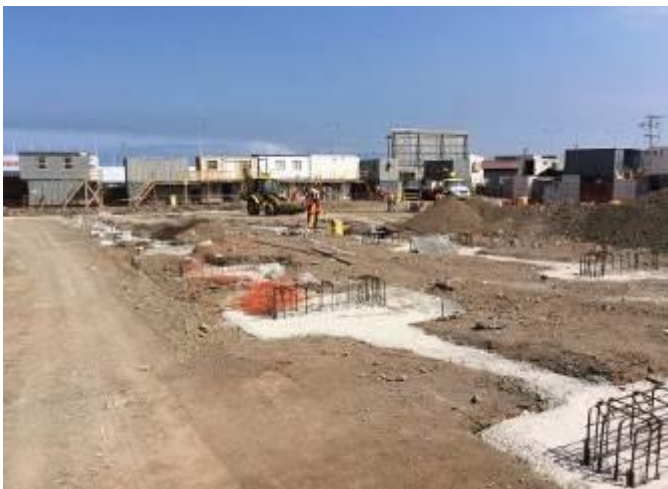
Movimiento de tierra y hormigonado de fundaciones en sector de estacionamientos
