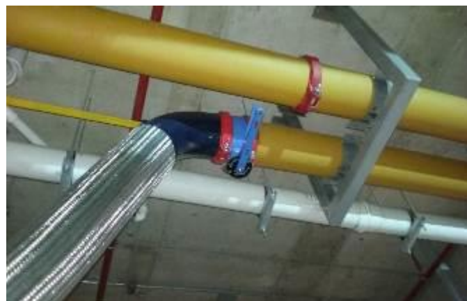
Válvula de mariposa para cañerías de agua en central térmica
