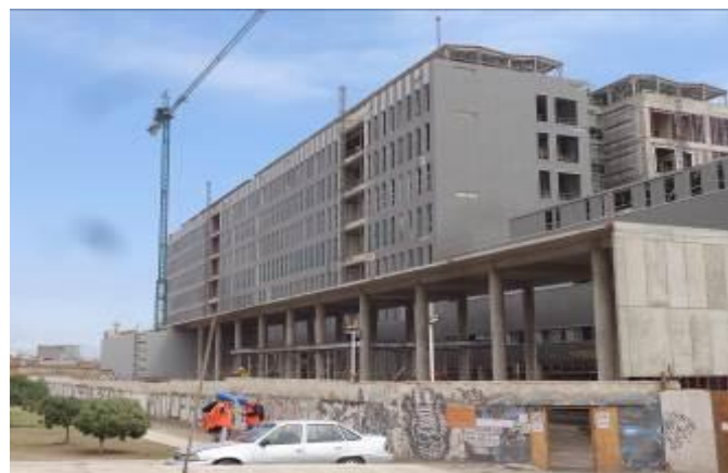
Obra gruesa TH
