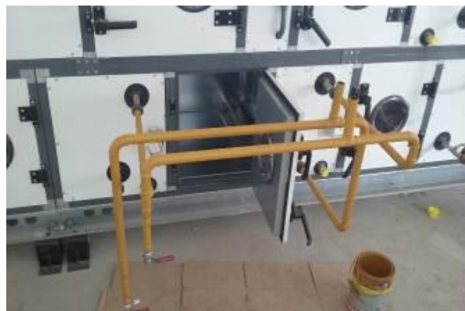
Instalación de cañerías de suministro de agua para UMAS
