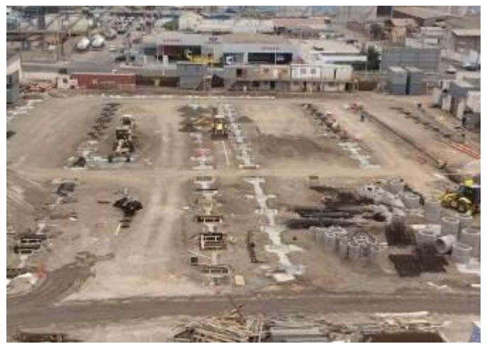
Movimiento de tierra y hormigonado de fundaciones en sector de estacionamientos
