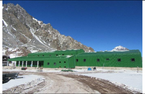
Edificio de Carabineros
