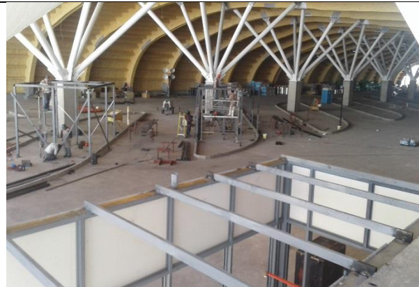
Edificio de Control – Vista interior
