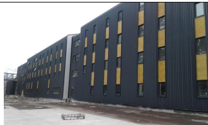
Edificio de Alojamiento
