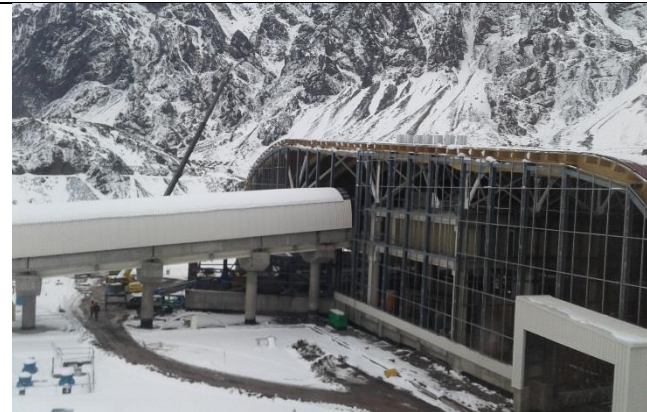
Edificio de Control – Vista norte
