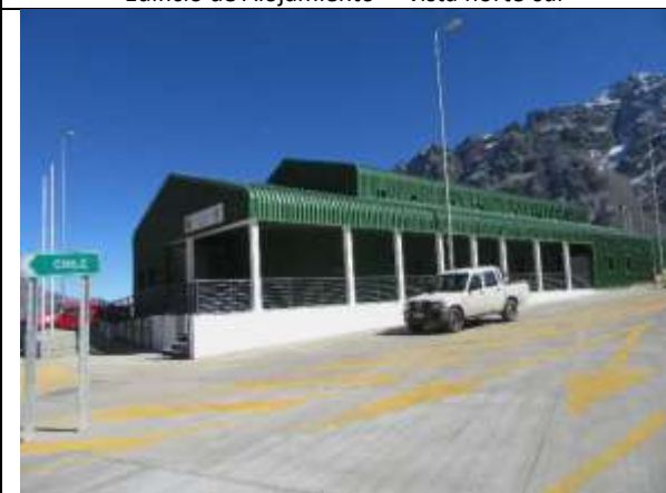
Edificio de Carabineros - vista norte-sur
