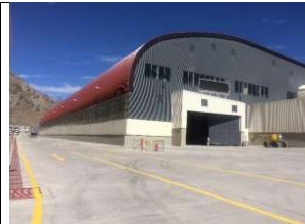
Edificio de Control y Servicios - vista norte-sur
