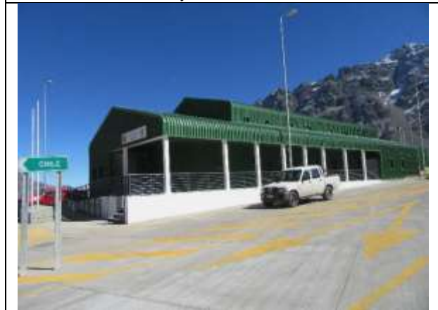
Edificio de Carabineros - vista norte-sur
