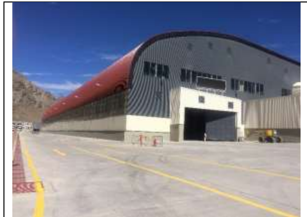
Edificio de Control y Servicios - vista norte-sur
