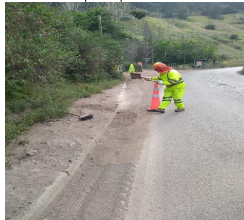
Imagen N°6 Limpieza cuneta revestida
