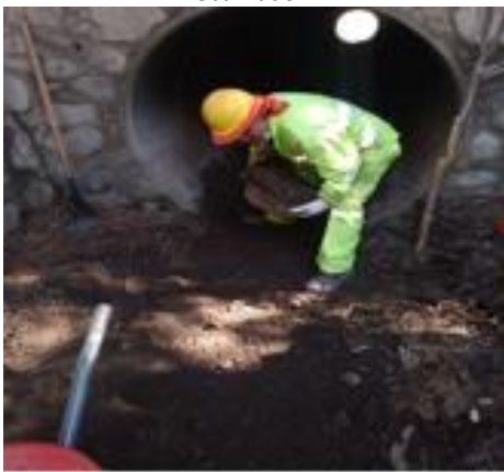
Imagen N°2 Limpieza de alcantarillas
