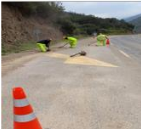
Imagen N°3 Limpieza de faja
