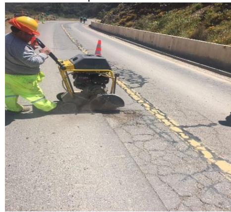
Imagen N°5 Corte para reparación de baches
