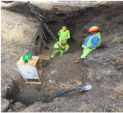
Imagen N°4 Limpieza de alcantarillas
