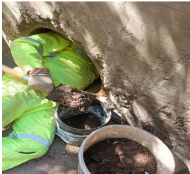
Imagen N°5 Limpieza de alcantarillas
