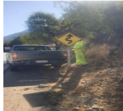
Imagen N°9 Instalación Placa de señal zona de curvas
