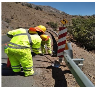
Imagen N°7 Instalación Hito Vertical
