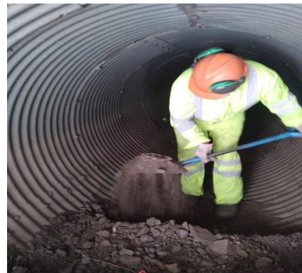
Imagen N°3 Limpieza de alcantarillas
